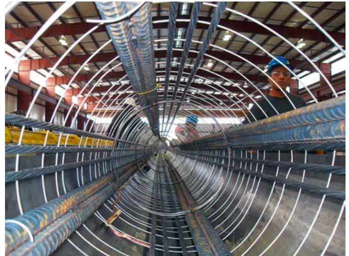
Mögliche Masten-Bewehrung Example of Pole Reinforcement
