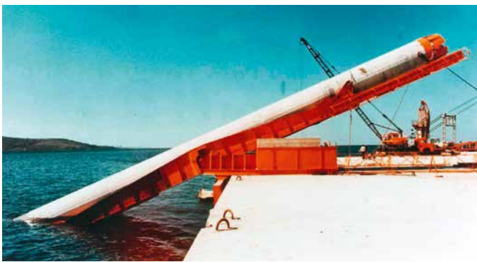
Betonpfähle als Stützen für Hafenplattformen Concrete Pile used for Harbor Platform Support
