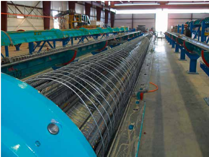
Schleuderbetonmasten-Form mit Bewehrung Spun Pole Mould with Reinforcement
