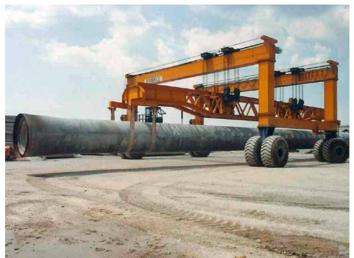
Krantransport eines 40 Meter langen Betonpfahls Transport Crane used for a 40 meter long Pile
