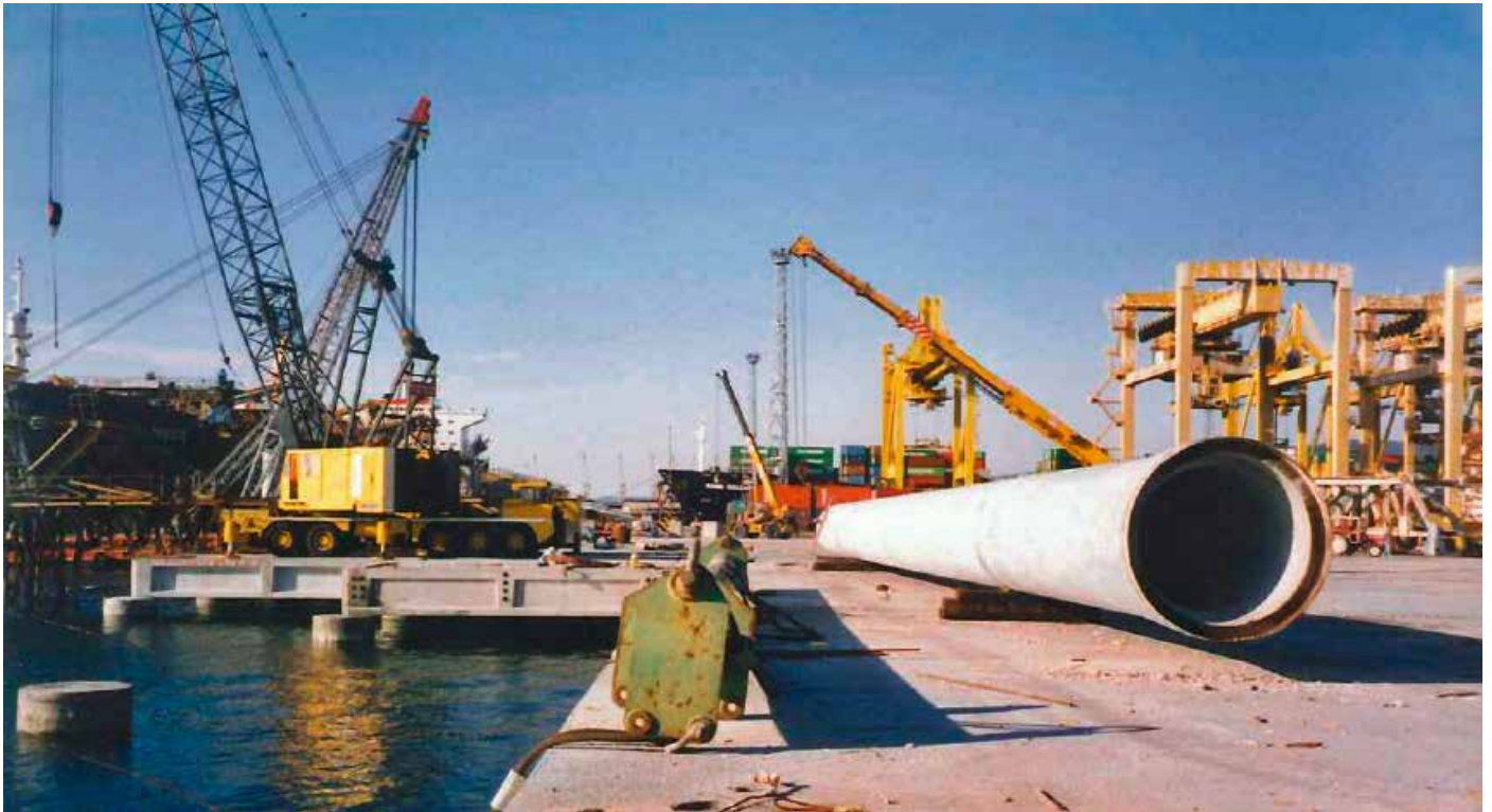
Betonpfähle als Stützen für Hafenplattformen Concrete Pile used for Harbor Platform Support
