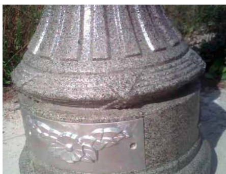
Detail des Unterteils eines Beleuchtungsmasts Detail of the bottom part of a Lighting Pole
